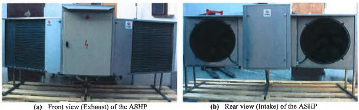
FIGURE 3.25 *HP-IRL'S* TC MACH CHAMELON AIR SOURCE HEAT PUMP.
