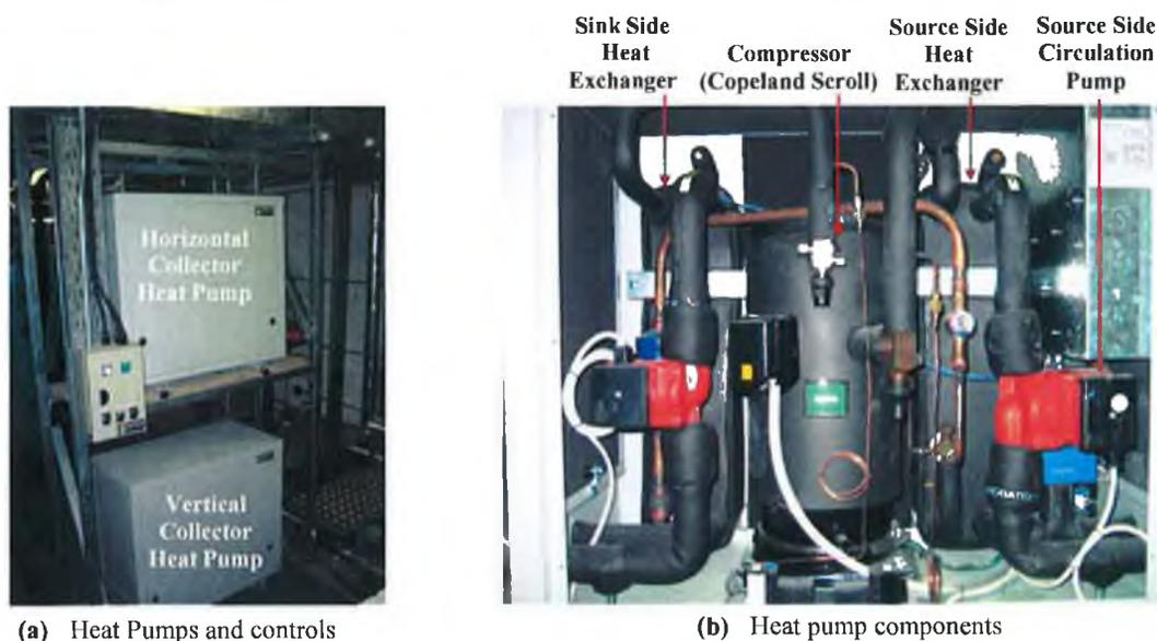
FIGURE 3.13 SOLTERRA 500 HEAT PUMP INSTALLATION COMPONENTS.
