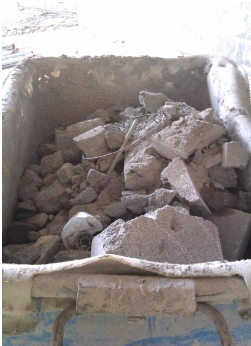
Photograph 5.31: Day 4. Mini rubble bin
